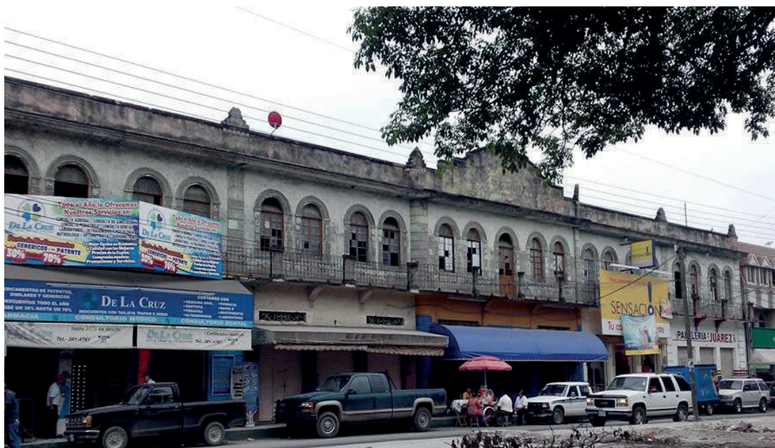
Figura 22. Edificio Altamirano. 1940. Subdividido en su planta baja, muestra fehaciente de la existencia de edificios relevantes que pasan desapercibidos en la imagen del paisaje y que en 2017 se encuentra en franco deterioro. Fuente: Archivo Luis Bárcenas.
