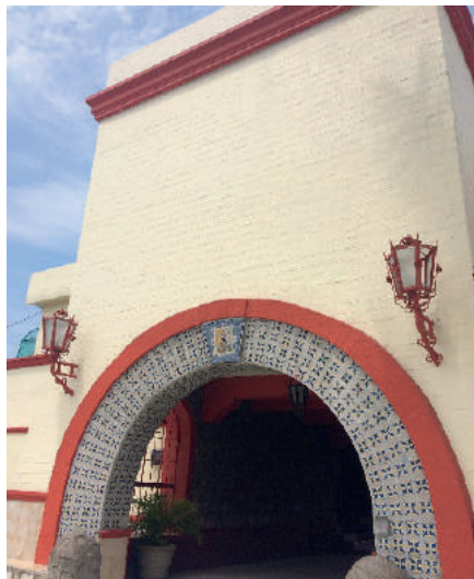
Figura 18. Hotel Casa Grande transformado hoy en Hotel Misión, persistencia del arco de acceso, ventanas superiores tapiadas y repellado texturizado. Fuente: Alejandra Martínez, Julio de 2017.
