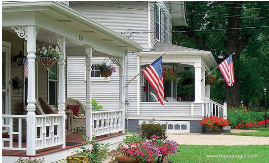
Figura 2. Casa de madera tipo estadounidense 5
