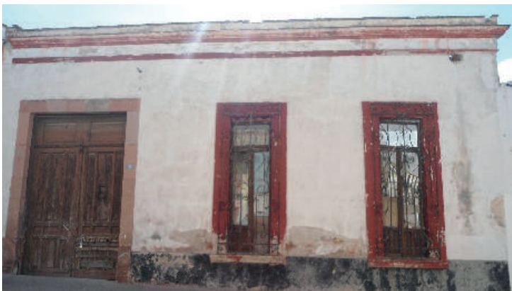
Figura 11. Inmueble ubicado en Ignacio Altamirano No. 3, Centro Histórico, Querétaro.
