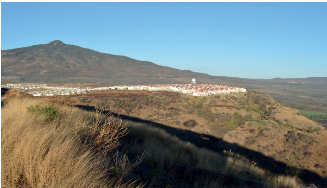
Figura 21. Vista del Fraccionamiento Hacienda del Sol, se integra por casas habitación de interés social, sin infraestructura básica de servicios. Fotografía del autor.
