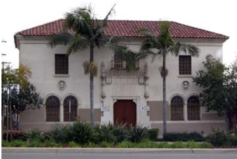
SDG&E Co., Substation F, 3169 El Cajon Boulevard.
